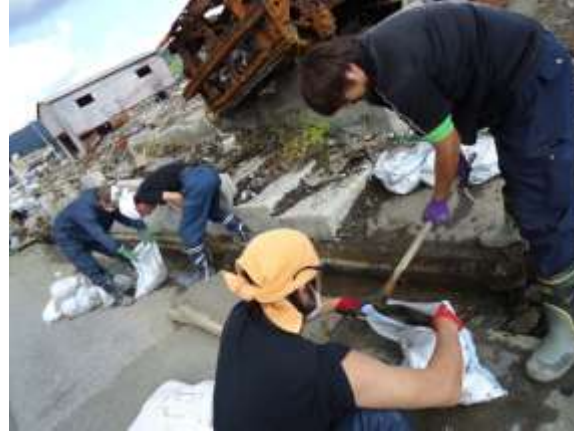
側溝の泥上げ
